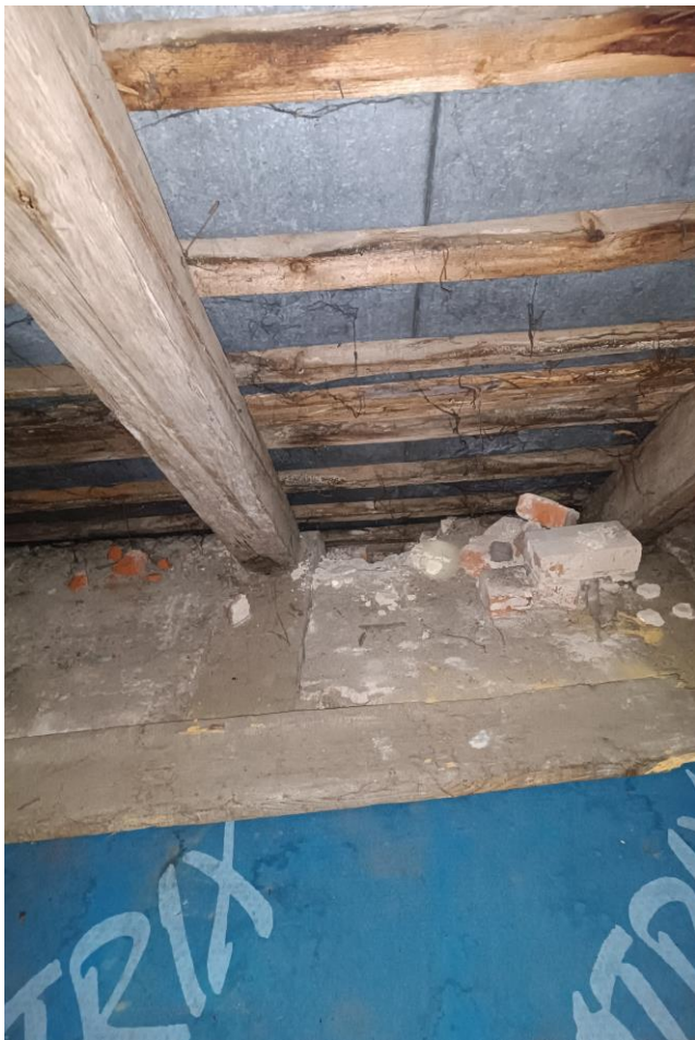
Fot. 3 Odkrywka w miejscu oparcia krokwi na ścianie północnej nad prezbiterium.
