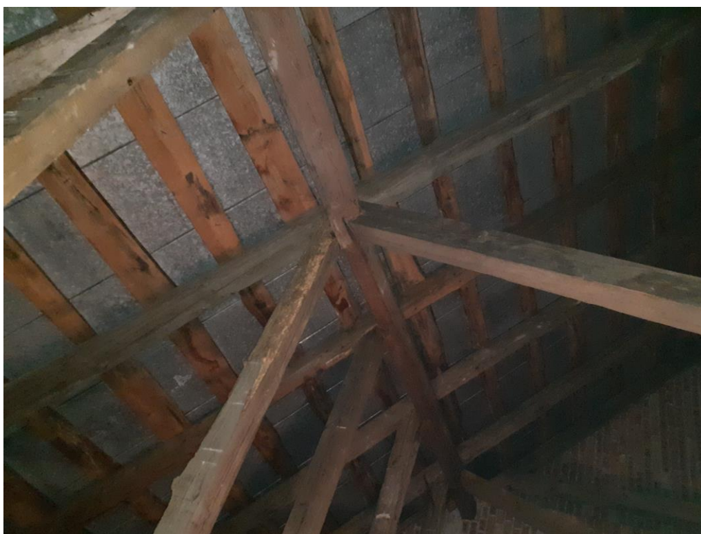
Fot.1 Widok na deskowanie połaci dachowej pokrycie dachowe
