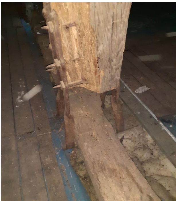
Fot. 4 Węzeł łączący krokiew z jętką z oparciem na płatwi z mieczami i słupką nad prezbiterium.
