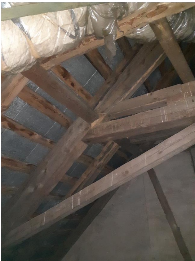
Fot. 7 Węzeł boczny wieszara „W1”
