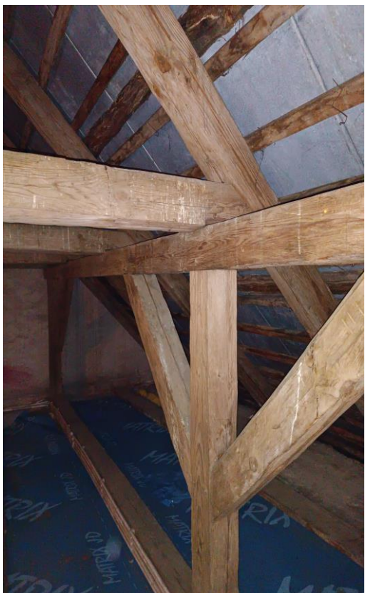
Fot. 4 Węzeł łączący krokiew z jętką z oparciem na płatwi z mieczami i słupką nad prezbiterium.
