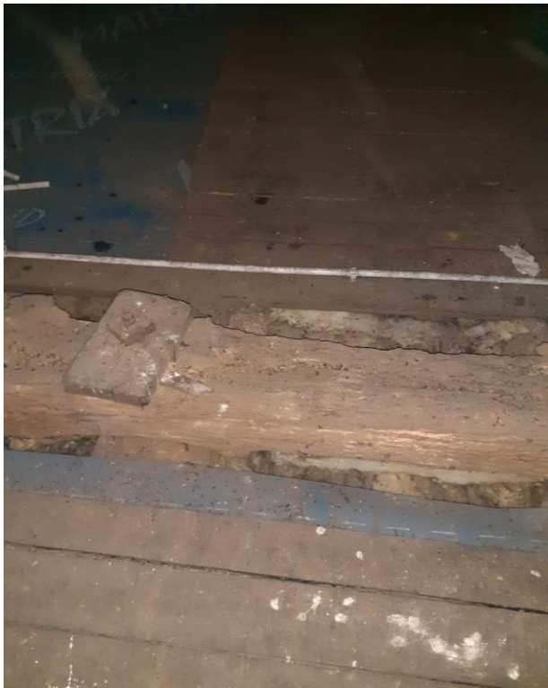
Fot. 6. Połączenie śrubowe belki stropowej z tramem
